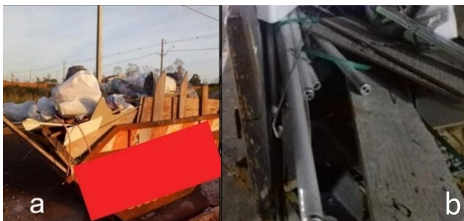
Figura 8 - Caçambas para acondicionamento dos RCC encontradas nas vias públicas do município de Campo Mourão-PR: a) aproveitamento do volume de modo irregular, b) resíduo perigoso (lâmpadas fluorescentes)
