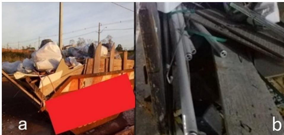
Figura 1 - Caçambas para acondicionamento dos RCC encontradas nas vias públicas do município de Campo Mourão-PR: a) aproveitamento do volume de modo irregular, b) resíduo perigoso (lâmpadas fluorescentes) Fonte: Equipe Técnica (2019)
