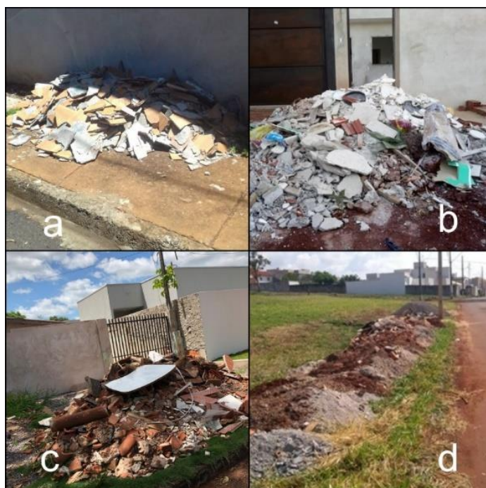
Figura 9 - Descartes irregulares de RCC nas vias públicas do município de Campo Mourão-PR (a – Jardim Cidade Nova; b – Jardim Lar Paraná; c – Jardim Copacabana; d – Jardim Flor de Lis).
