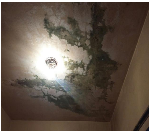
Condições da laje e forro devido á problemas no telhado;
