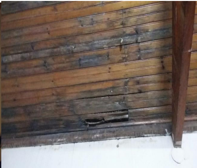
Condições da laje e forro devido á problemas no telhado;
