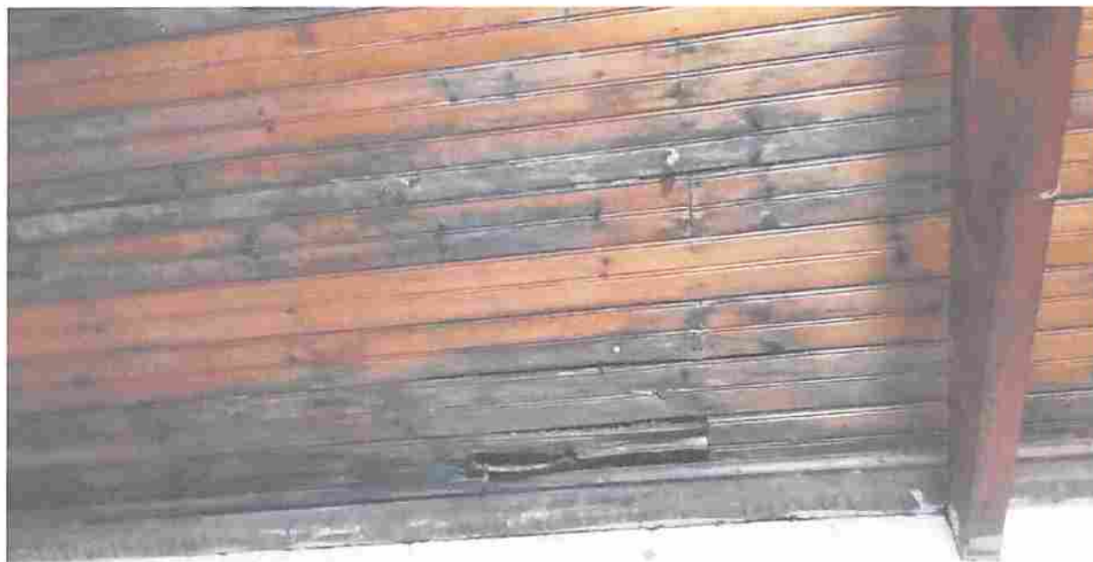
Condição do forró, devido á problemas no telhado.
