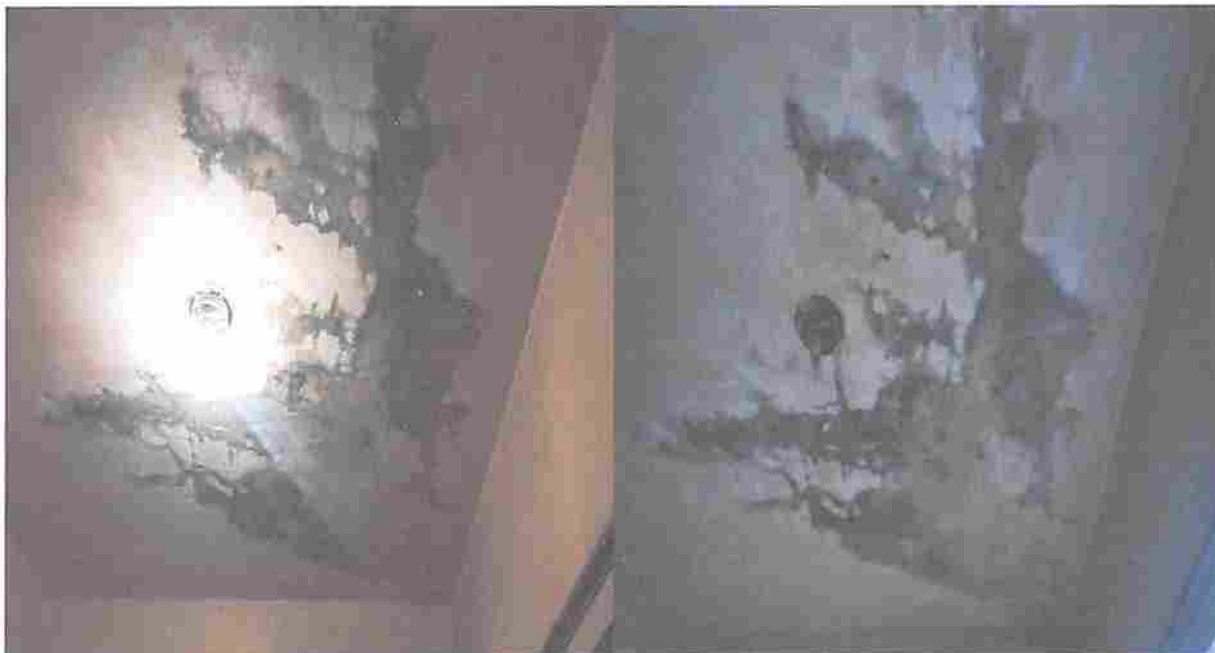
Condição da laje, devido á problemas no telhado;
