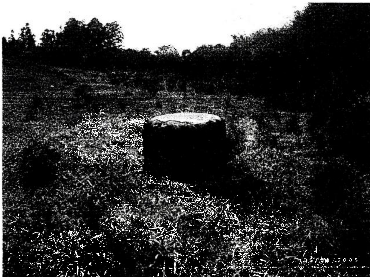
POÇO DE VISITA EM EMISSARIO DE ESGOTO SANEPAR - EM AREA PROPOSTA DE PARQUE
