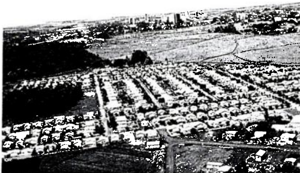
CONJUNTO HABITACIONAL PARIGOT DE SOUZA Campo Mourão - PR
