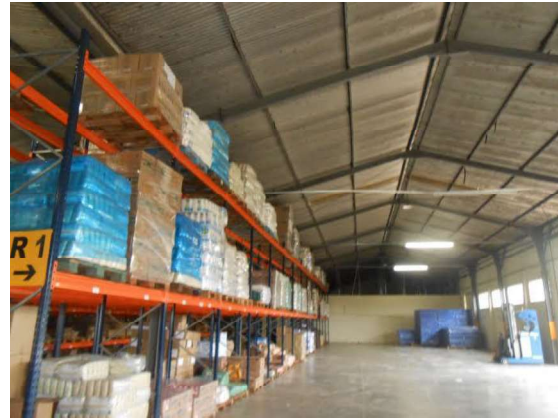
Figura 4: Central de Abastecimento de Maringá
