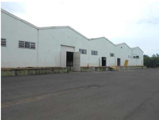
Figura 3: Central de Abastecimento de Maringá
